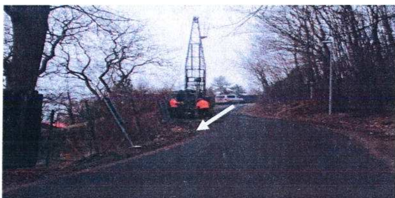
Obrázek 2 nestabilita krajnice způsobená odtokem vody z komunikace
